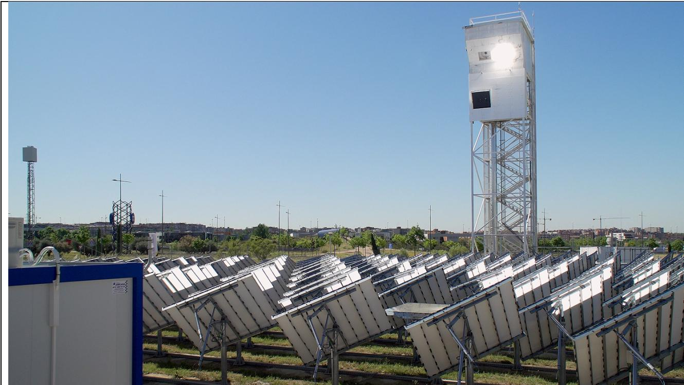
**Titel:** SUN-to-LIQUID Solaranlage zur solaren Herstellung von Kerosin
